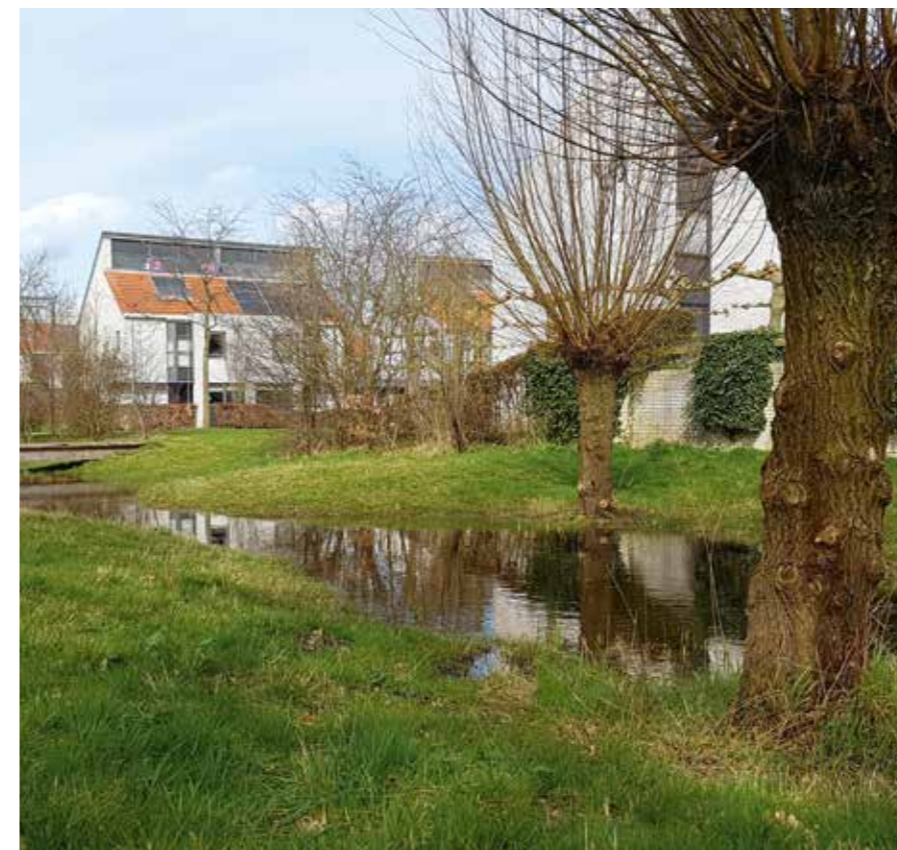
Een bestaande wadi in Breda waar na een regenbui nog water in staat. Buitenlands onderzoek toont aan dat een beplante wadi 4 tot 30% meer water kan bergen doordat planten ook water opnemen.
